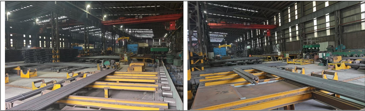
图 3.1.1 项目位置现场照片
